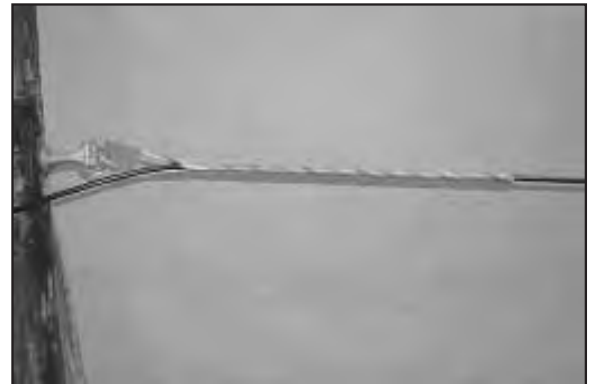
Completado la instalación y la tensión alterna quitados.
